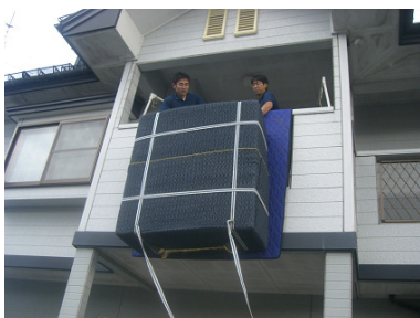
家具の吊上げ搬入
