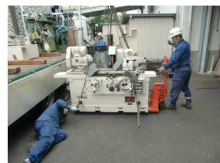
重量機械運搬 機械の設置も行います
